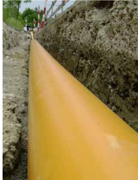
RCprotect® Hoher Sicherheitsstandard in der Praxis: RCprotect® Gasleitung der Erdgas Zürich AG
